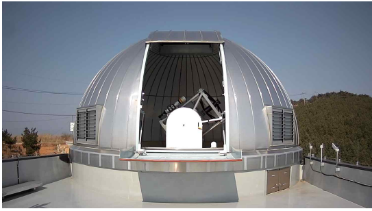
그림4. 한국천문연구원 거창 감악산 SLR 사이트 8.5미터 자동 제어 돔.
