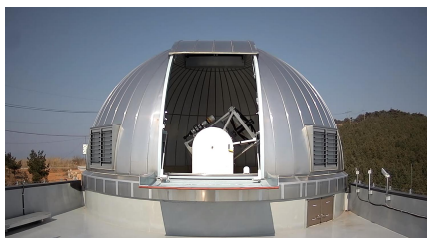
그림4. 한국천문연구원 거창 감악산 SLR 사이트 8.5미터 자동 제어 돔.
