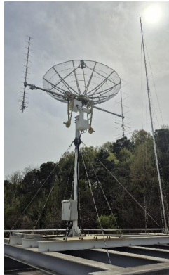
큐브위성 전용 안테나 구축 (S band 및 VHF/UHF 안테나)
